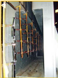
Fig.14 Túnel de secado
