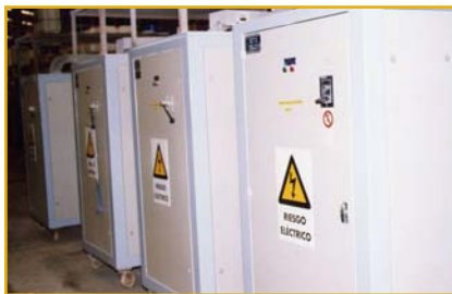
Fig.3 Rectificadores de un taller de anodizado
