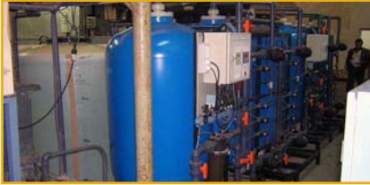
Fig. 31 Instalación de intercambio iónico para el reciclaje de aguas de enjuague
